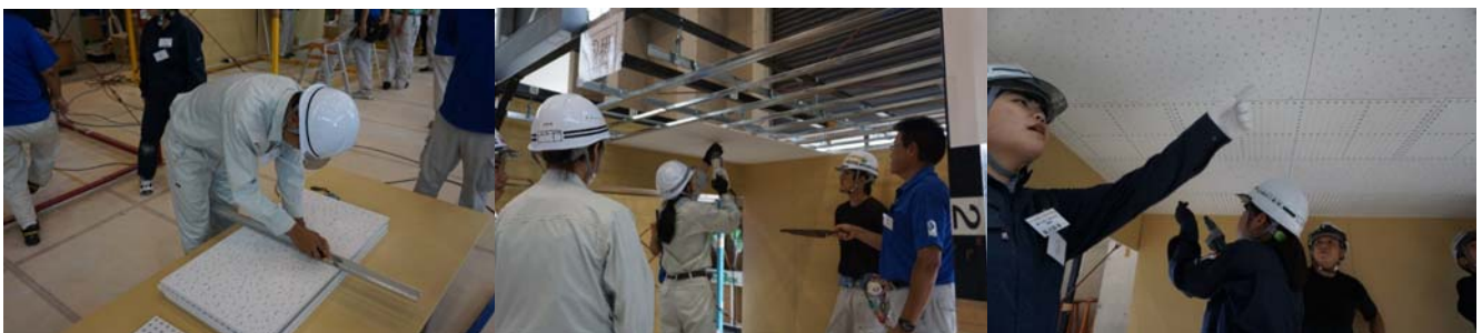
・天井ボード貼
