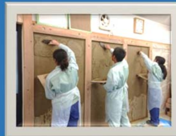
土壁(塗り付け、中塗り、仕上)
