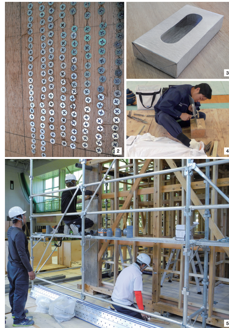
2: ビス打ちの練習跡。右から左へ、日と共に上達している様子が分かる。 3: 鉄板を曲げてつくるティッシュボックスづくりの課題は、ものづくりの楽しさを知ると共に金属屋根の加工技術を養うための基礎訓練という側面もある。 4: 体育館内にも多くの実習設備が設けられている。
