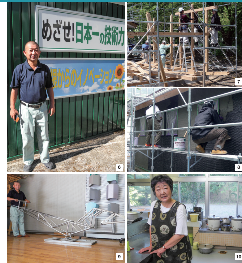
6: 利根沼田テクノアカデミーの校長を務める桑原敏彦さん。 7: 大工コースでは土台据え・柱立てから下地・造作など大工の一連した工程を学ぶ。次の工程である左官・瓦や板金・水道設備に繋がり、一軒の建屋が完成していく。全コースがこの建屋を使用して実践訓練を行っている。 8: 本年より新たに加わった左官コースの実践訓練では、校庭に建てられた建屋を利用し実践感覚を磨くと同時に、仲間意識や協調性を高めていく。 9: 利根沼田テクノアカデミーではさまざまな商品開発も行われている。写真は重量のある金属屋根の運搬を容易にする運搬機器「沼田テクノキャリア」。 10: 訓練生には地域の食材をふんだんに使った美味しい食事が提供される。
