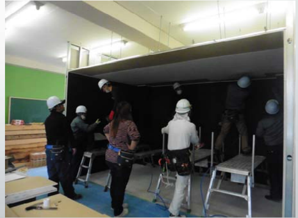
軽天ボード・化粧合板施工
