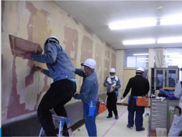
クロスの下地補修・張り替え
