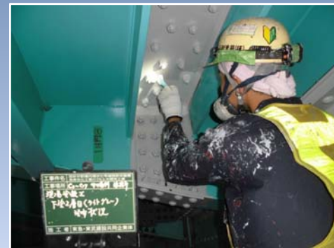
土木橋梁塗装
