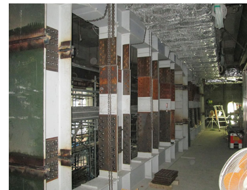
躯体一式工事
