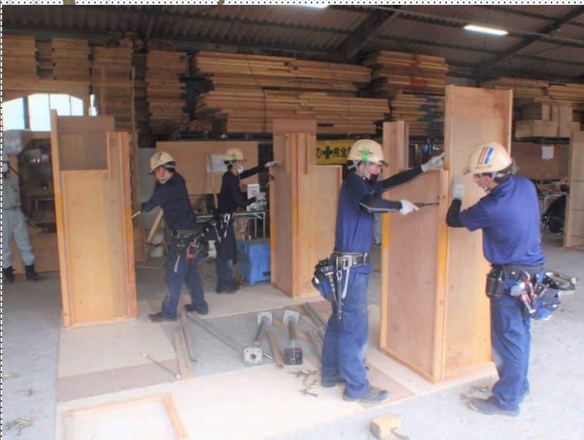
柱 型枠建込み状況
