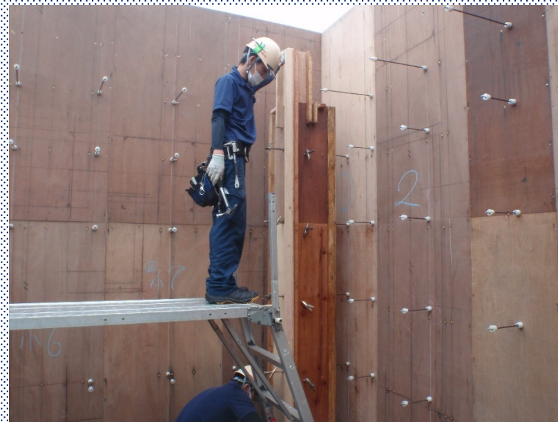
柱 型枠建込み状況と型枠の建込み状況
