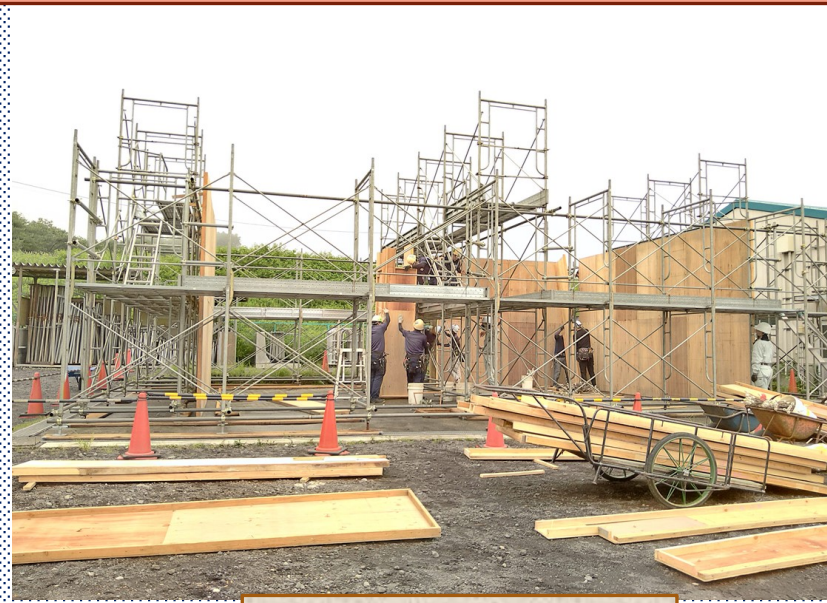
型枠の建込み状況
