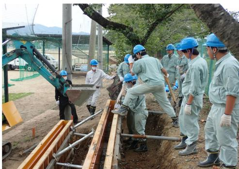
上2段の擁壁部コンクリート打設
