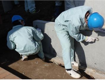
擁壁部分のセパレータ処理
