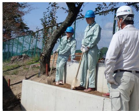
上2段の擁壁部型枠脱型・整地
