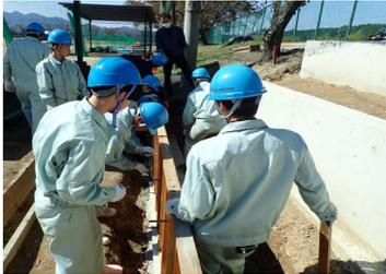
下1段の型枠設置
