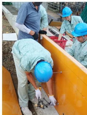
上2段の型枠設置（セパレータ取付け）
