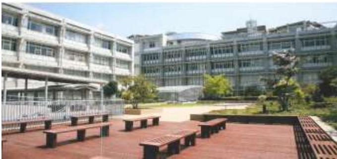
以前の4号館屋上のベンチ
