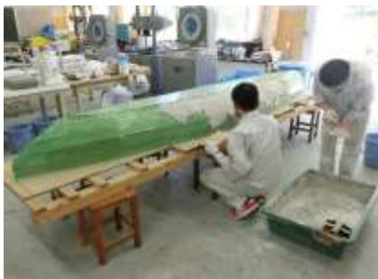
⑤コンクリート打ち込み
