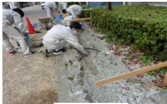
▲漏水止め施工
