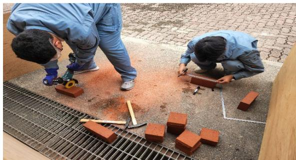
・型枠を設置し、レンガを積み上げ、水平器とゴムハンマーで調整を行った。
