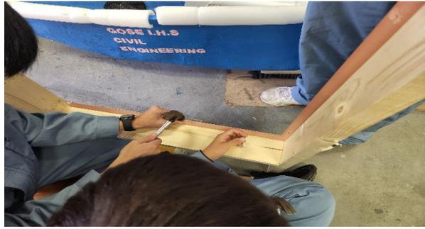
・レベルを使って高低差を求め、基礎コンクリートの型枠を水平に設置する。
