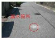
漏れることなく漏水箇所を特定
