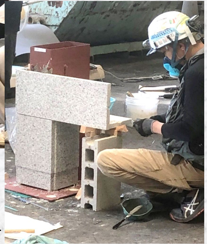
吊りもの据付
