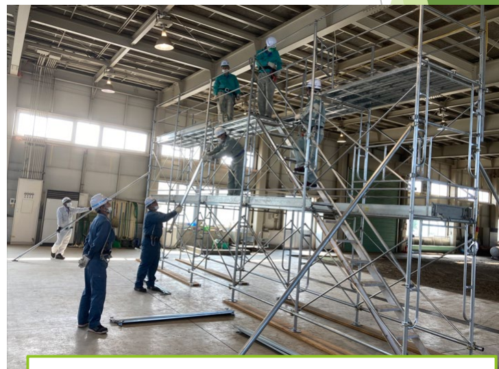
「足場組立作業実技」
